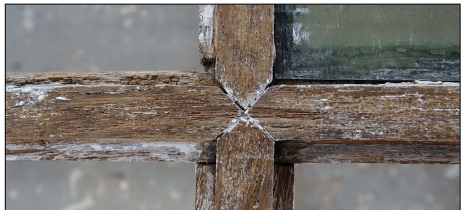
Fig. 2.4. Assemblage des petits-bois
