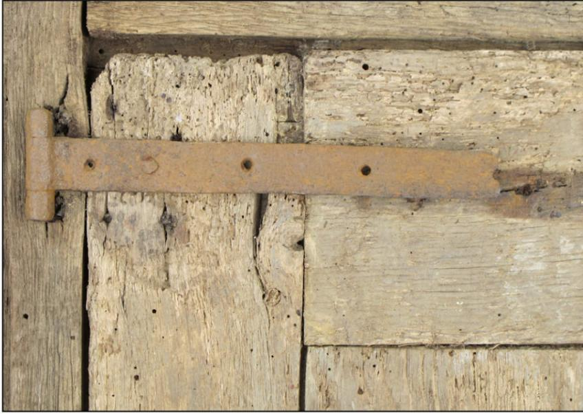
Fig. 2.1. Penture (volet inférieur gauche)
