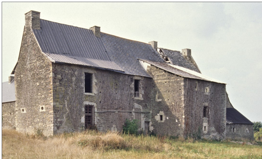
Fig. E.3. Façade postérieure et cage d'escalier, avant restauration (1996). Au rez-de-chaussée, près de la porte, la croisée murée B. A l'étage, immédiatement au-dessus, la croisée C.
