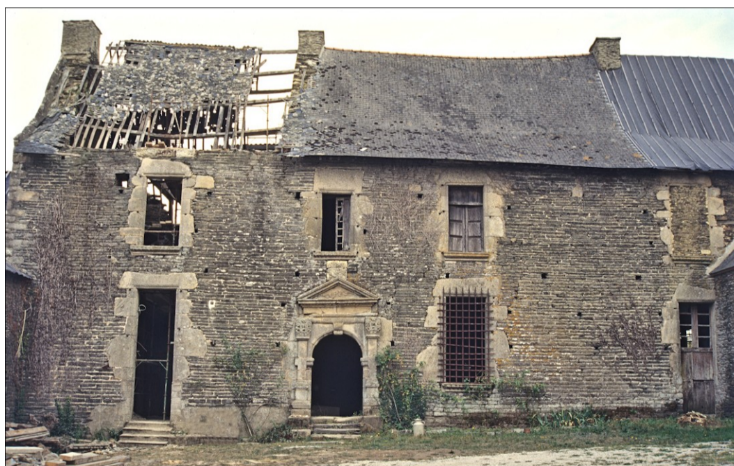
Fig. E.1. Façade antérieure sur cour, avant restauration (1996). A droite de la porte, la croisée A.
