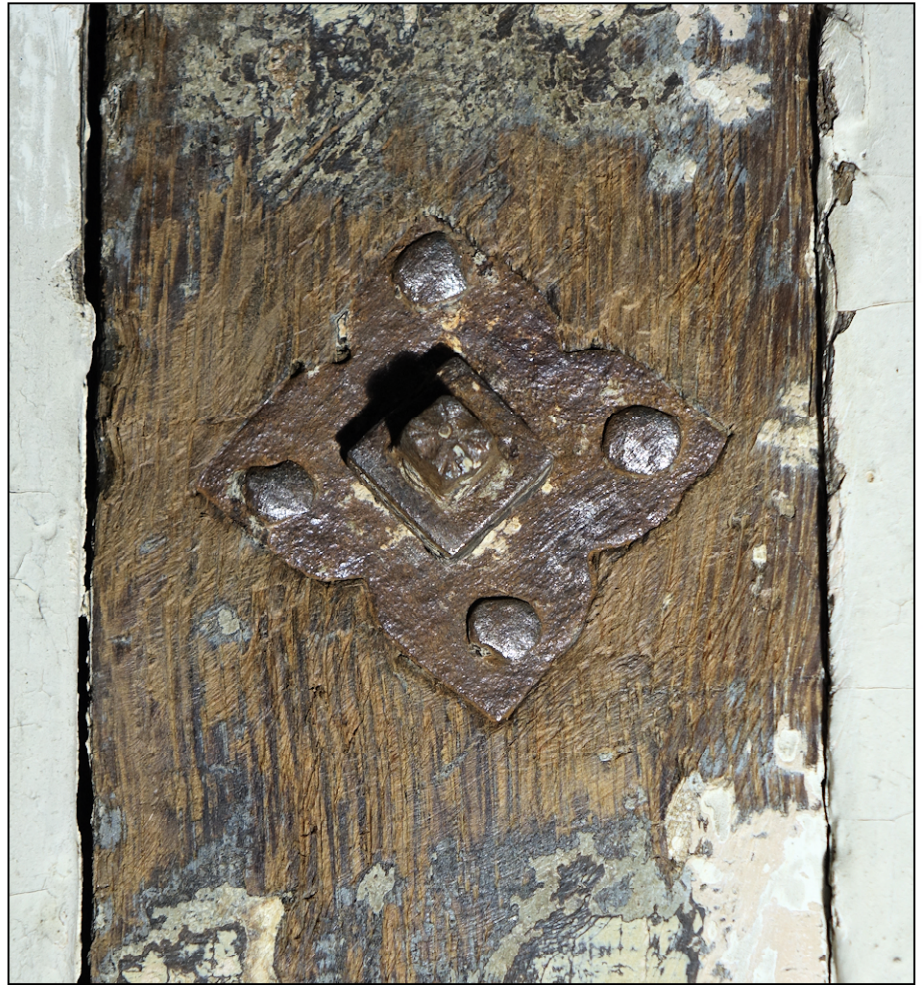
Fig. 10.2. Boulon sur rosace (croisée 2, meneau)
