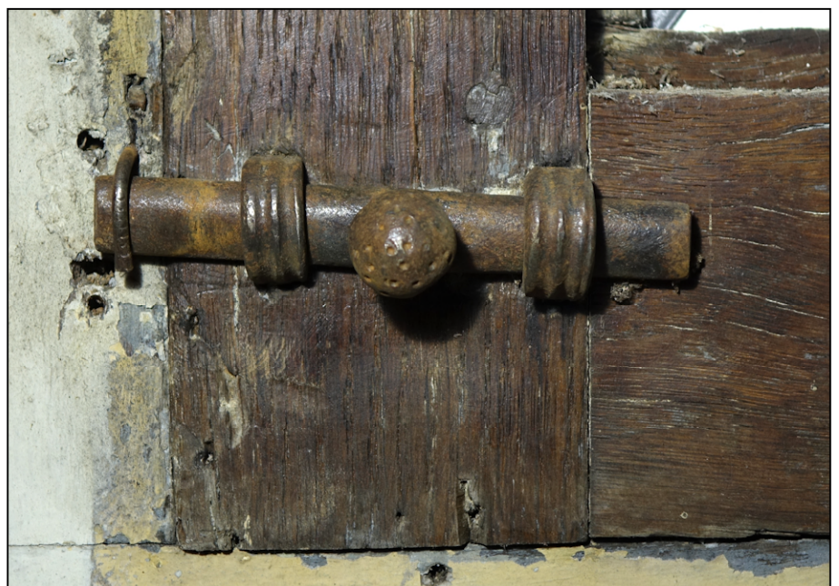
Fig. 10.4. Verrou (croisée 3, vantail vitré supérieur)
