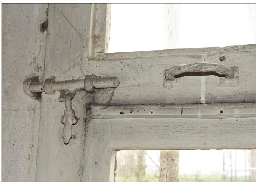
Fig. 7.3. Verrou et poignée (châssis 1)
