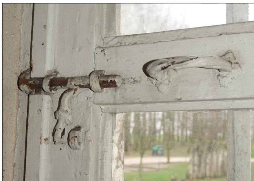
Fig. 7.4. Verrou et poignée (châssis 2)
