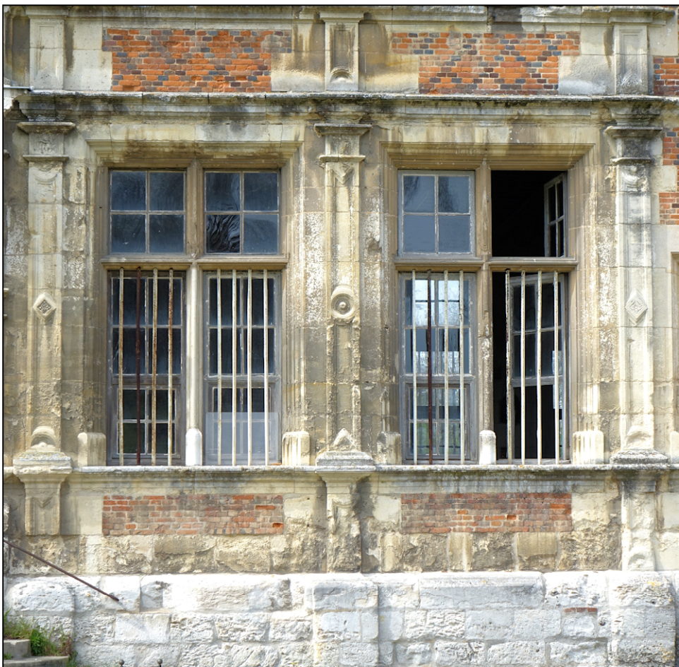
Fig. 2.3. Croisées 1 et 2 (façade sud)
