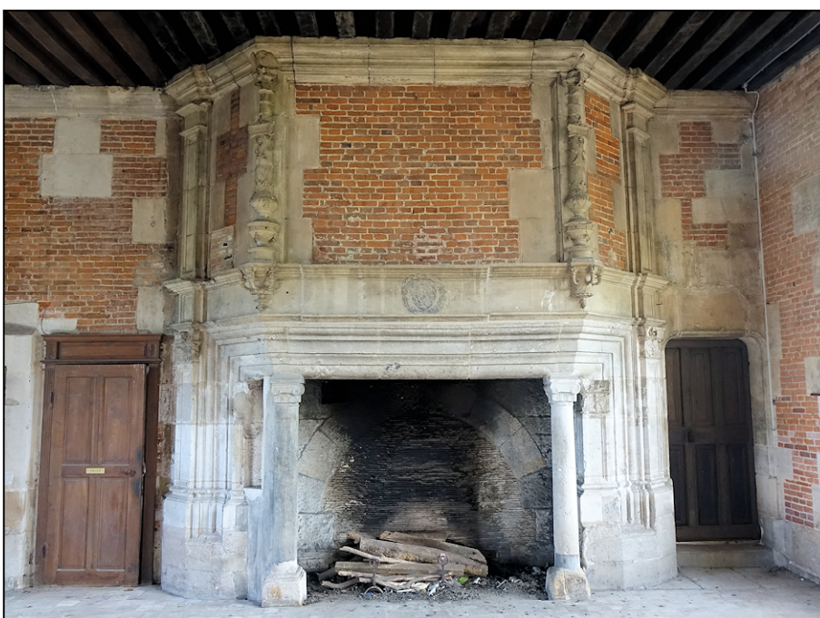
Fig. 2.5. Cheminée de la grande salle A droite, porte 1
