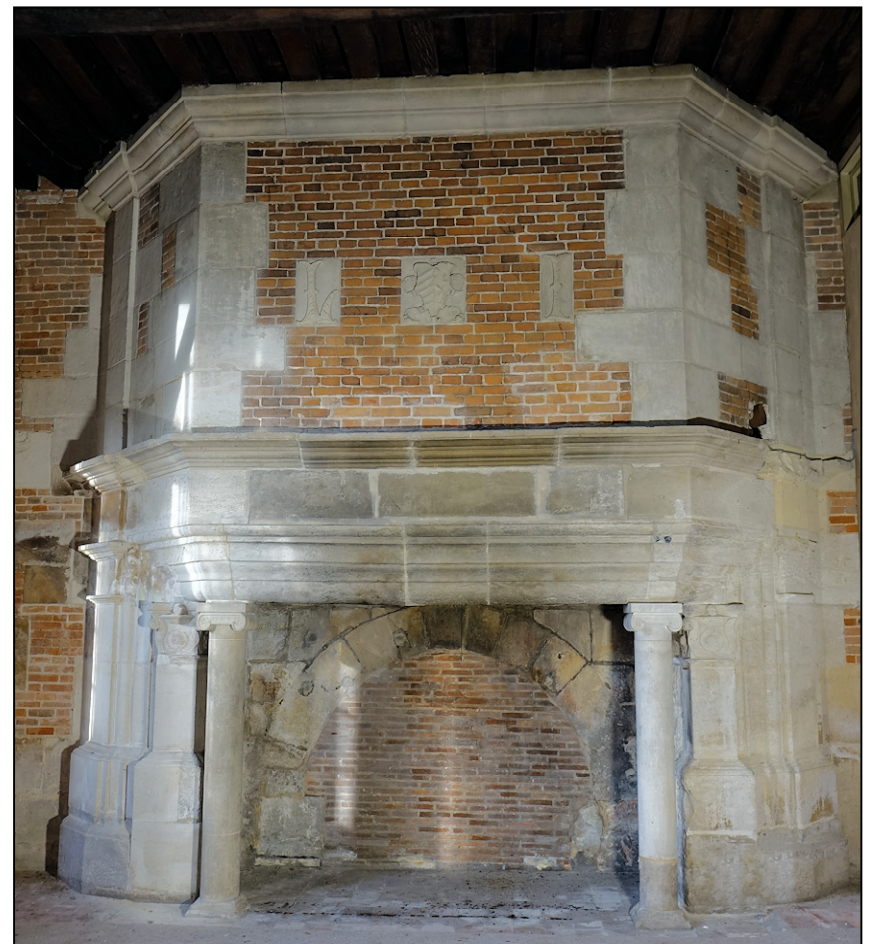
Fig. 2.4. Cheminée de la cuisine
