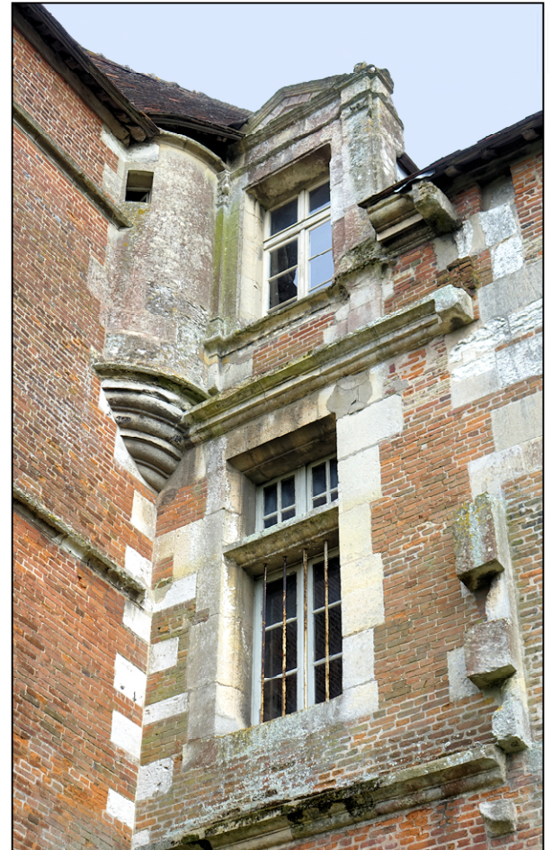
Fig. 2.2. Escalier (façade nord)
