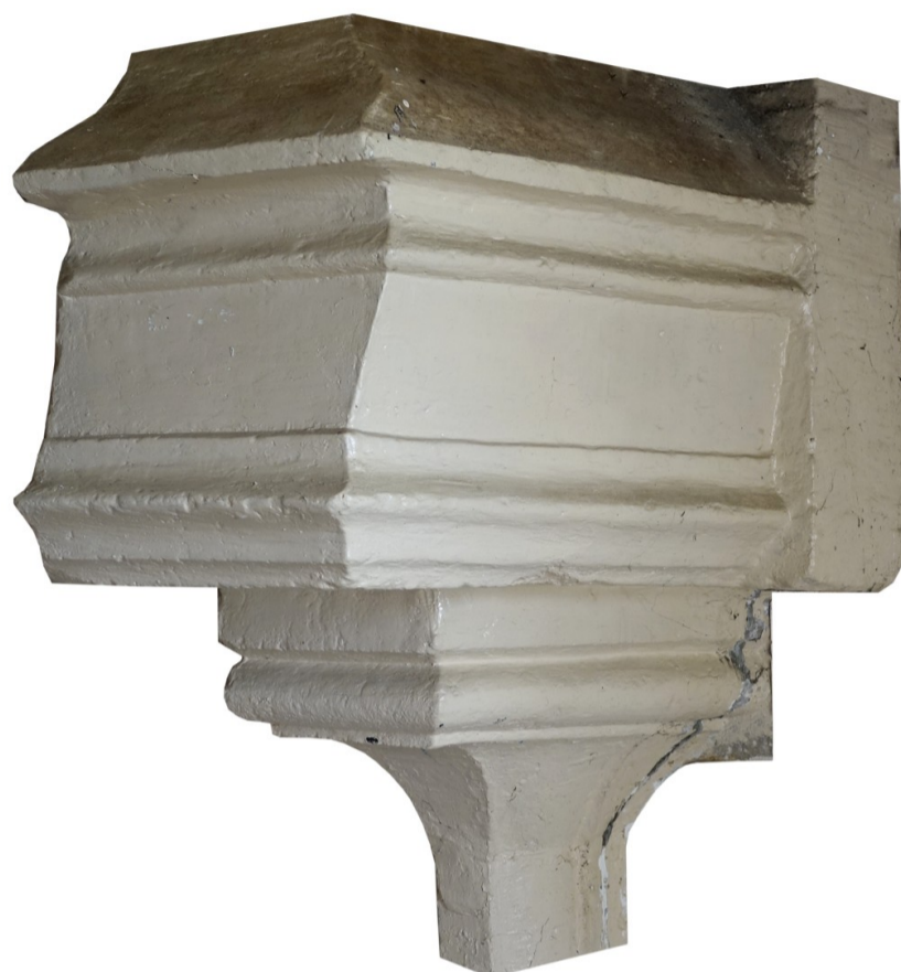
Fig. E.2 – Vestige d'une cheminée du rez-de-chaussée.
