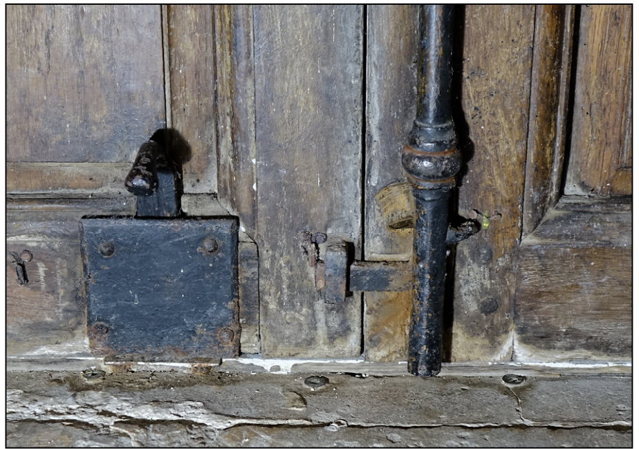
Fig. 8.3. Verrou et loquet fermé d'espagnolette
