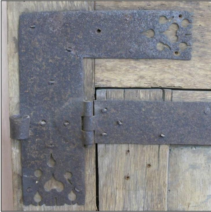
Fig. 2.1. Penture (angle supérieur gauche)
