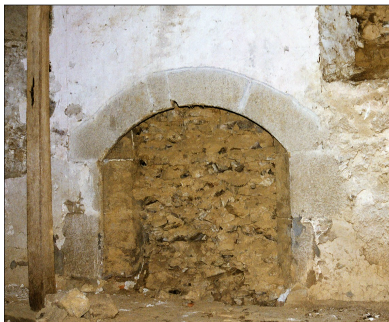
Fig. E.1. Cheminée du mur nord
