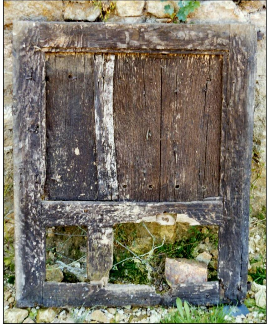
Fig. 1.2. Vantail vitré et volet inférieurs (élévation extérieure)
