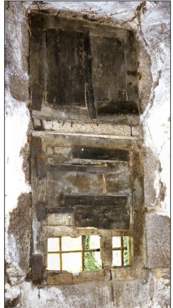
Fig. 1.5. Demi-croisée (élévation intérieure)
