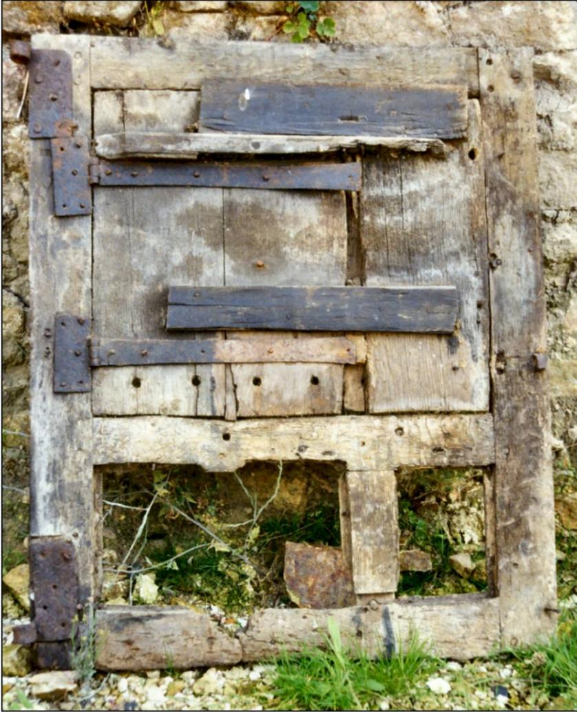
Fig. 1.1. Vantail vitré et volet inférieurs (élévation intérieure)
