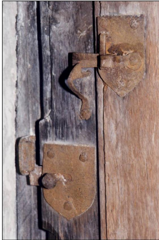
Fig. 3.4. Loquet et targette enclouonnée
