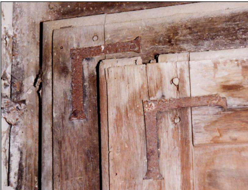
Fig. 3.5. Equerres (angle supérieur gauche)
