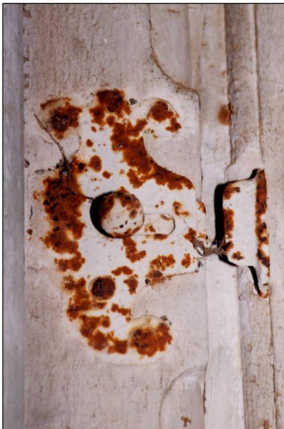
Fig. 2.5. Targette encloisonnée (vantail vitré inf.)
