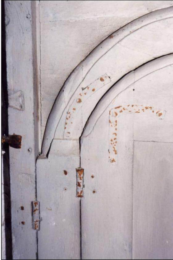
Fig. 2.2. Fiches et équerres (angle sup. gauche)
