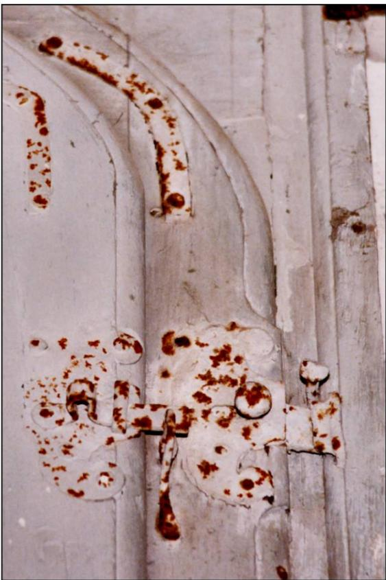
Fig. 2.4. Loquet et targette (compartiment sup.)
