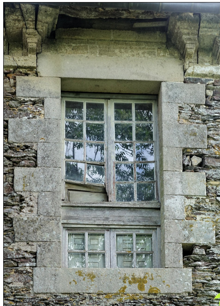
Fig. E.2 – Fenêtre de l'escalier (façade ouest, niveau 3)
