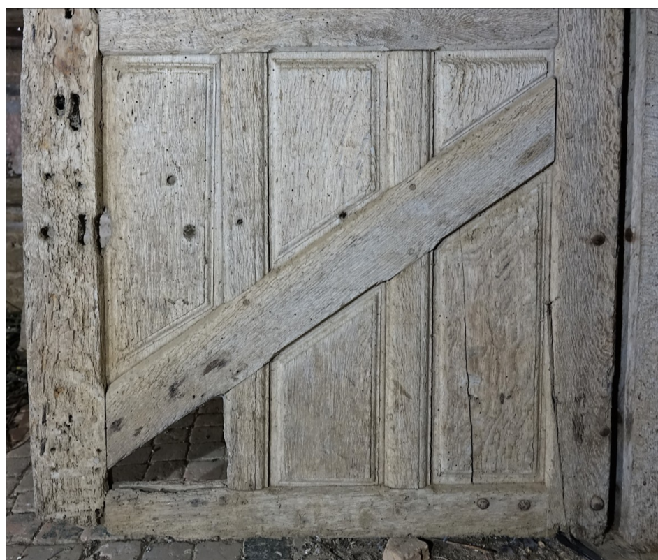
Fig. E.3 – Registre du bas d'une porte à panneaux avec écharpe assemblée (combles). L'écharpe à l'envers montre que son sens a été inversé.
