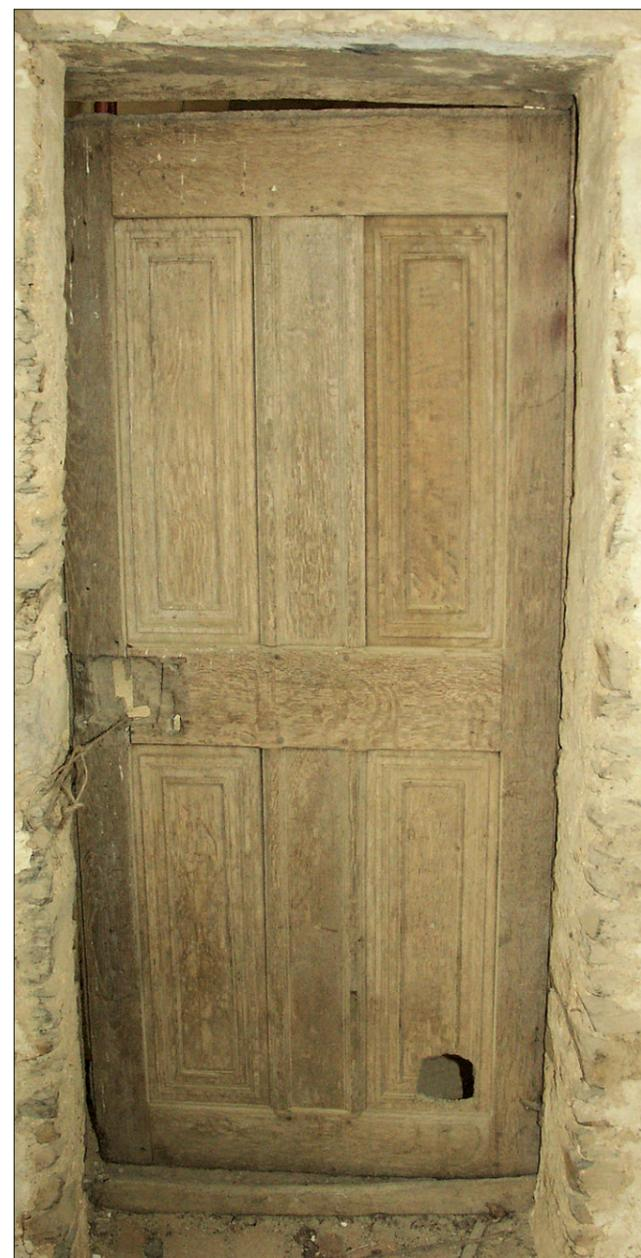
Fig. E.2. Vantail de porte avec élégis identiques au châssis B
