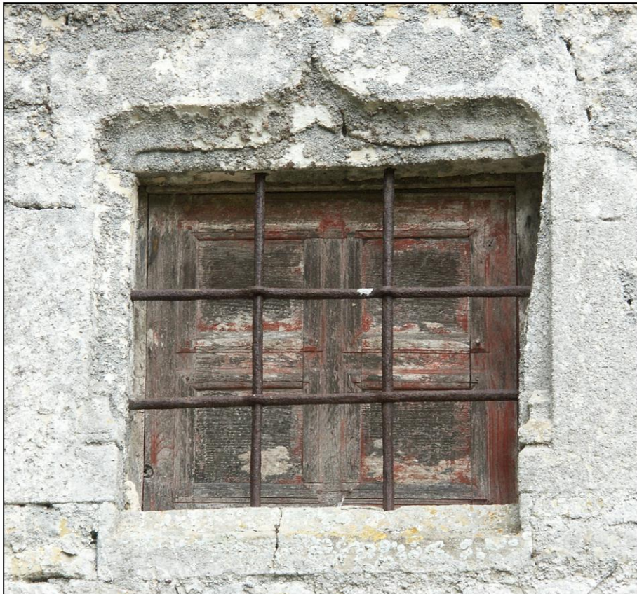
Fig. 5.1. Châssis du rez-de-chaussée
