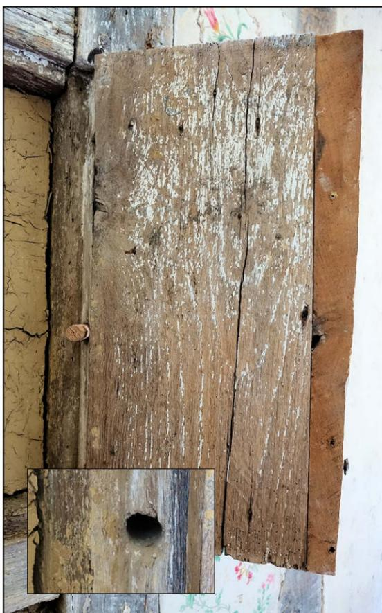
Fig. 3.5. Restitution du blocage du volet
