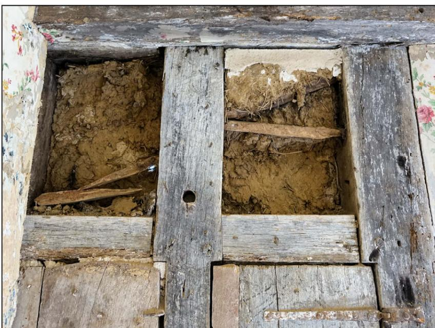
Fig. 3.7. Remplissage en torchis des compartiments supérieurs
