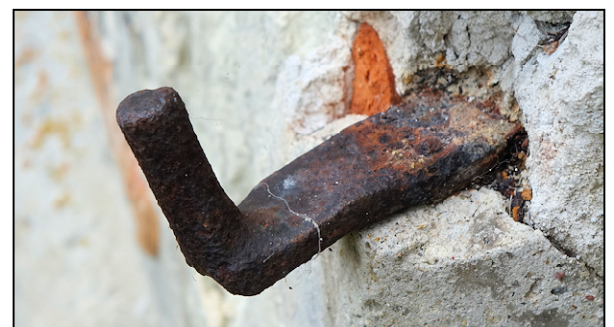
Fig. 4.5. Ferrures des contrevents
