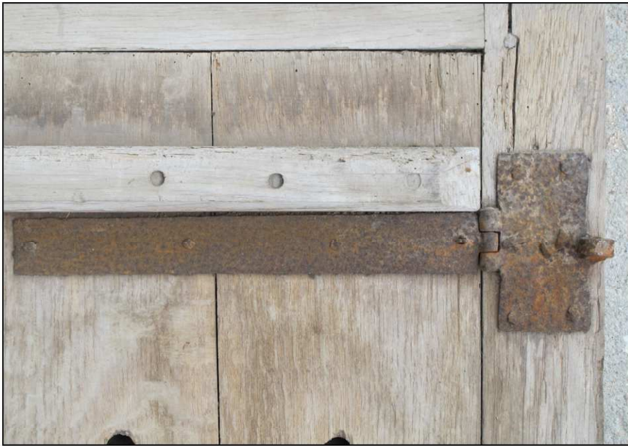
Fig. 2.1. Penture à charnière supérieure
