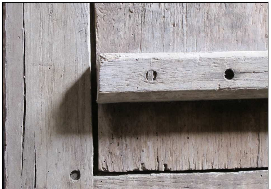
Fig. 2.6. Volet et barre chevillée
