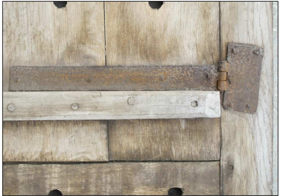
Fig. 2.2. Penture à charnière inférieure
