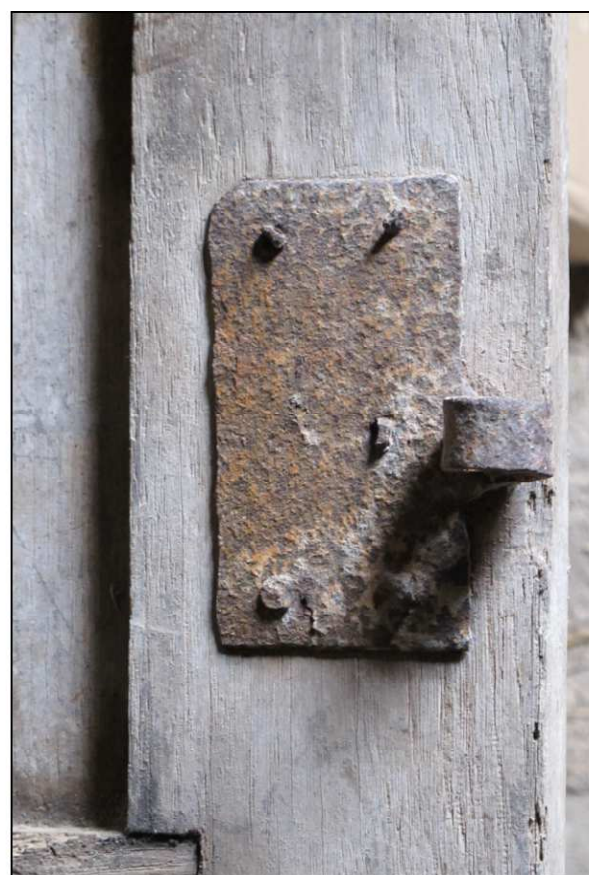
Fig. 1.5. Paumelle inférieure
