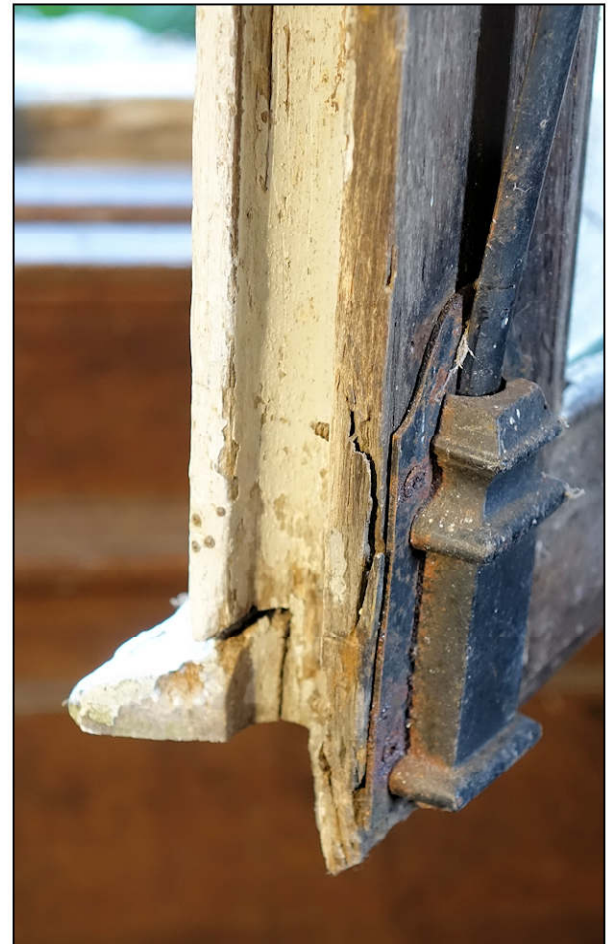
Fig. 5.6. Ballant à contre-noix
