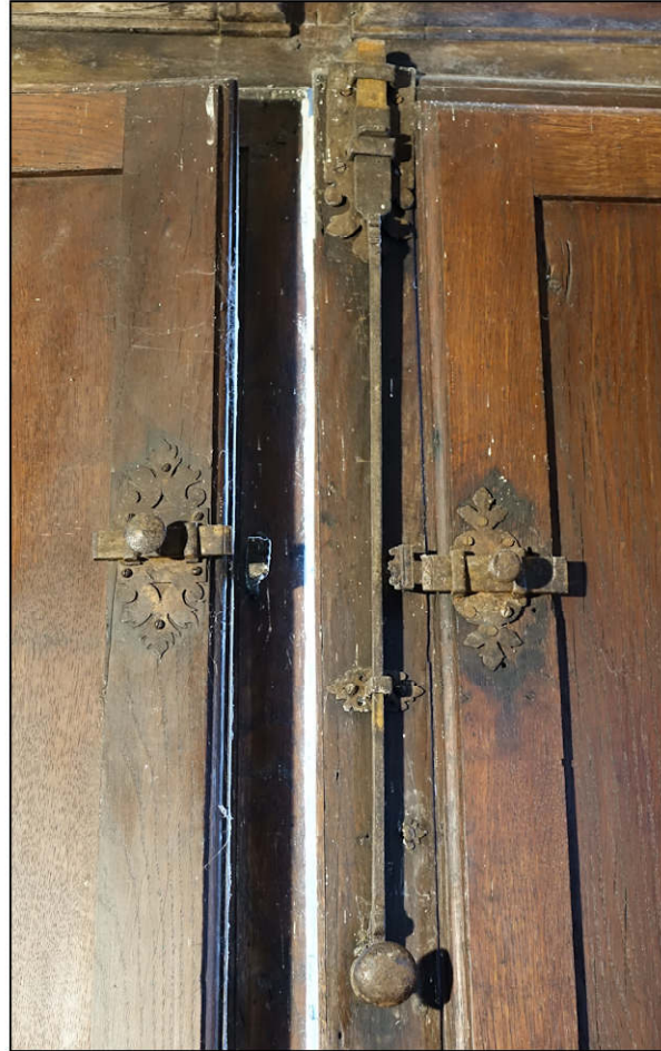
Fig. 5.2. Targettes et verrou supérieur
