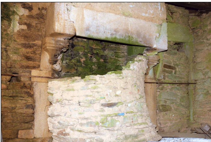
Fig. 1.5. Pignon ouest / cheminée
