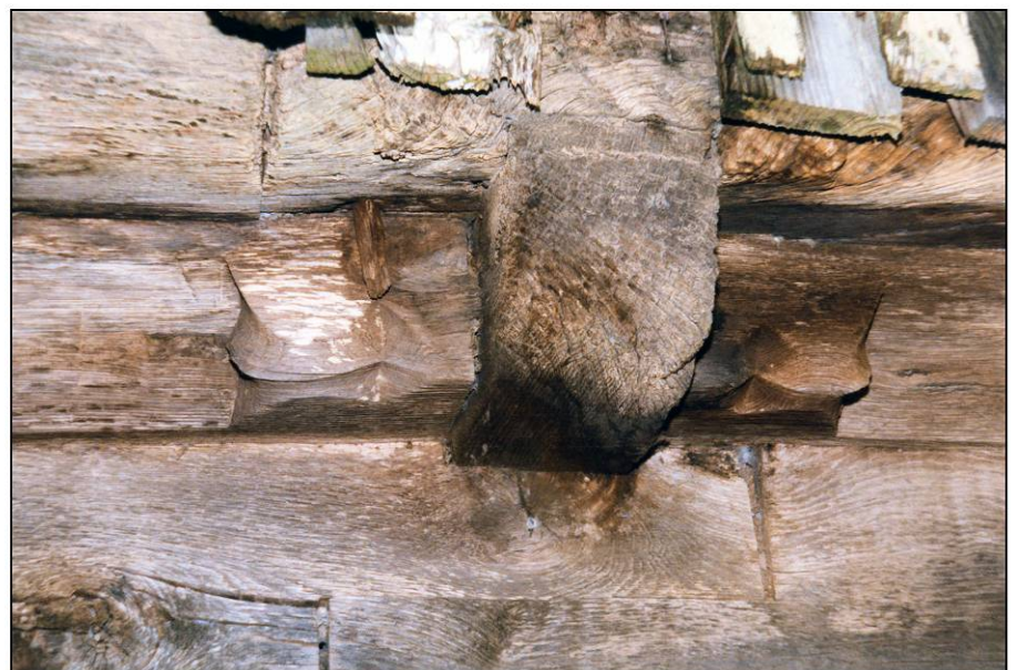
Fig. 1.6. Assemblage (poutre / solives / sablières)
