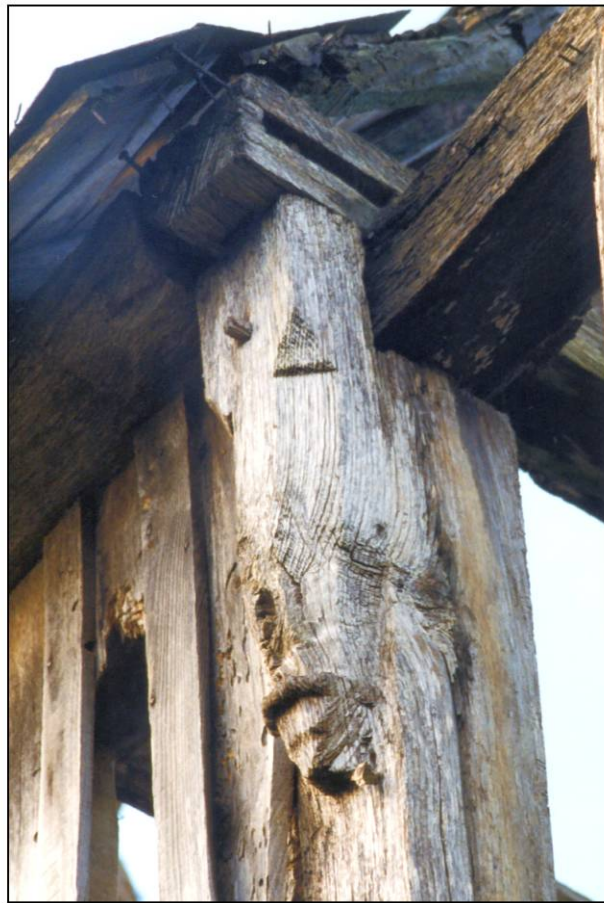
Fig. 1.4. Assemblage (poteau / sablière / entrait)
