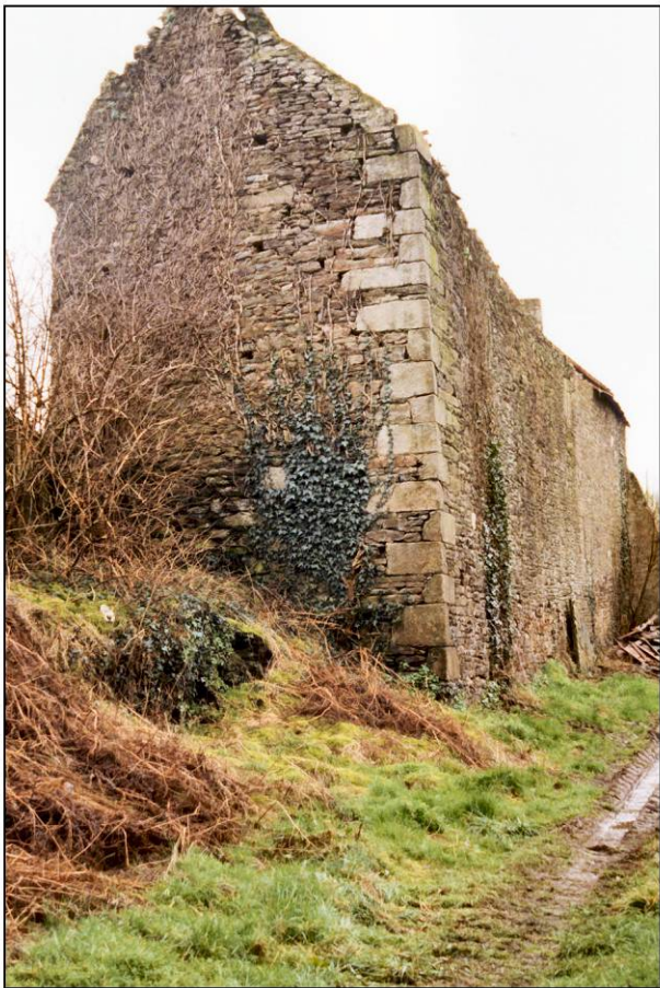
Fig. 1.3. Pignon est et façade nord
