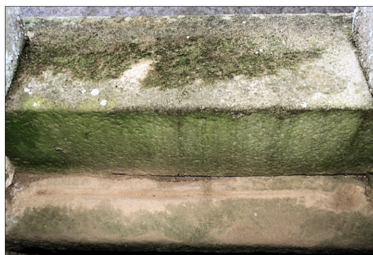
Fig. E.2 et E.3 - La lucarne du logis et son appui en pierre A noter le canal de récupération des eaux pluviales et son évacuation au centre, ainsi que l'alvéole, à droite, pour maintenir le pivot du volet (dispositions identiques au manoir de Kermeno à Moréac – étude n°56005)
