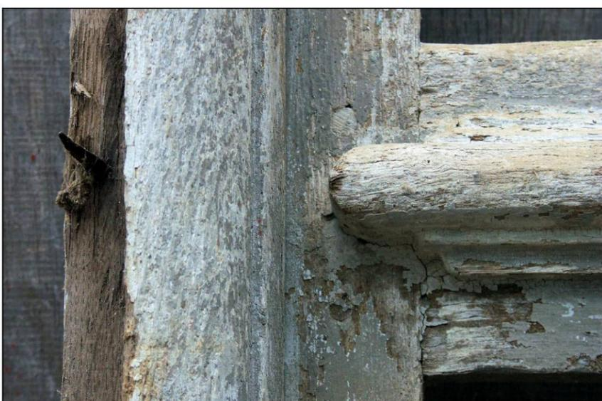
Fig. 3.7. Bâti dormant et traverse intermédiaire du vantail vitré
