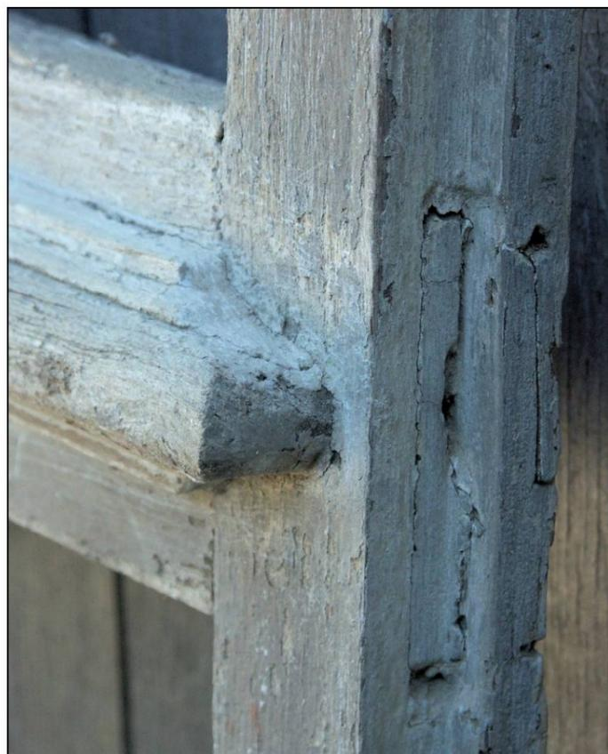
Fig. 3.5. Traverse intermédiaire flottée
