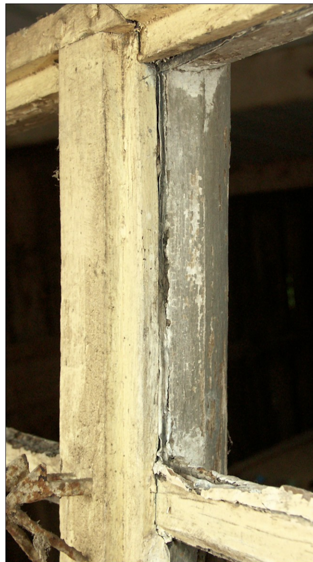
Fig. E.1. Mise en plomb d'un carreau de l'imposte
