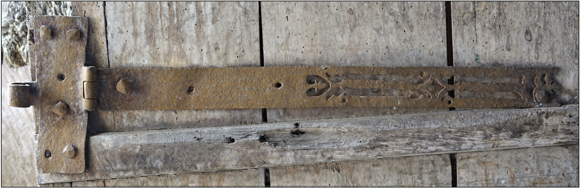
Fig. 4.1. Penture à charnière du haut du volet inférieur gauche
