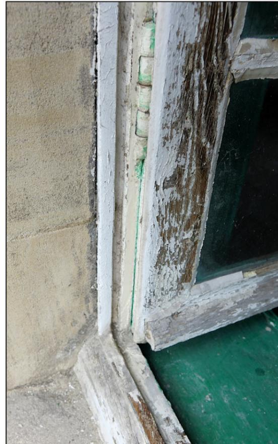
Fig. 7.3. Pièce d'appui et jet d'eau (A)
