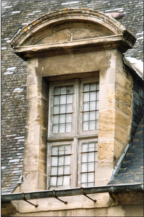
Fig. 4.1. Lucarne (façade est)
