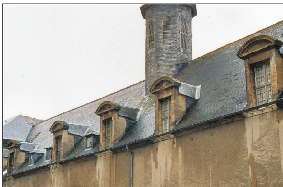
Fig. 1.4. Chapelle (façade est)
