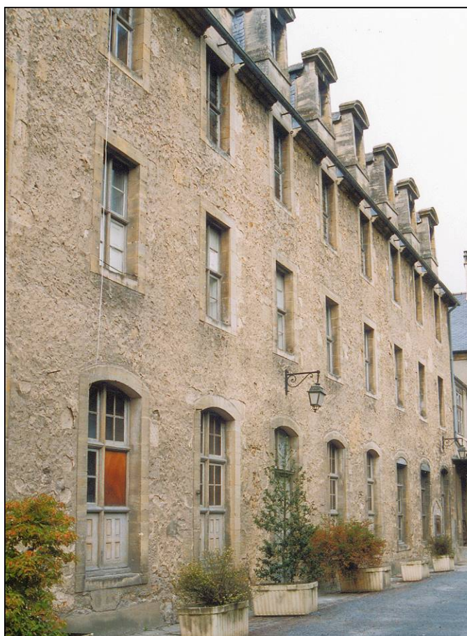
Fig. 1.3. Logis (façade est)
