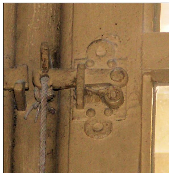
Fig. E.3. Loquet des croisées du rez-de-chaussée
