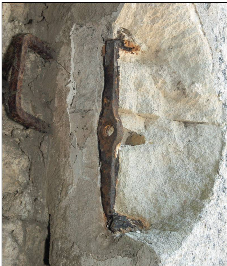
Fig. 3.4. Agrafe scellée dans le meneau
