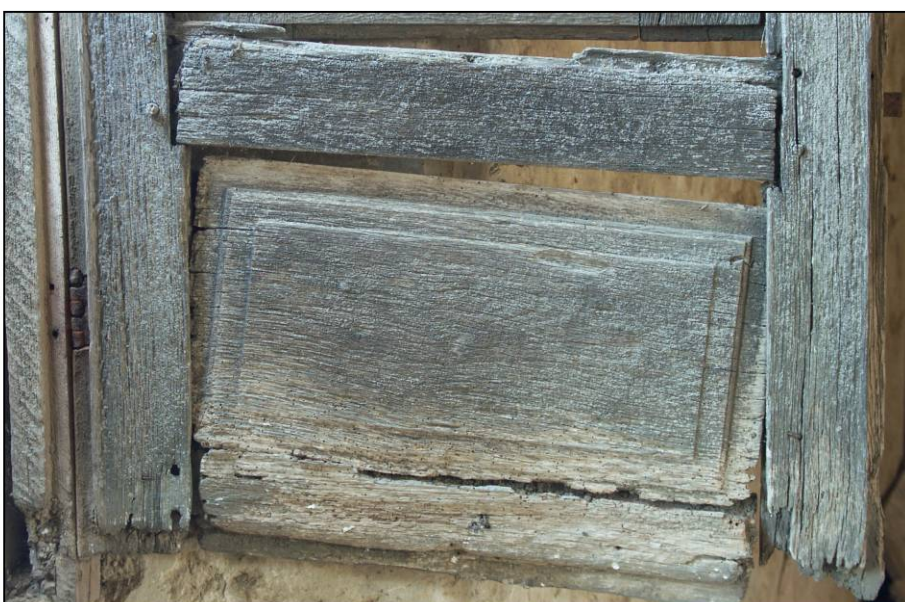
Fig. 2.5. Vantail vitré (soubassement à panneau)
