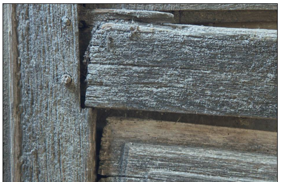
Fig. 2.6. Vantail vitré (détail du soubassement)
