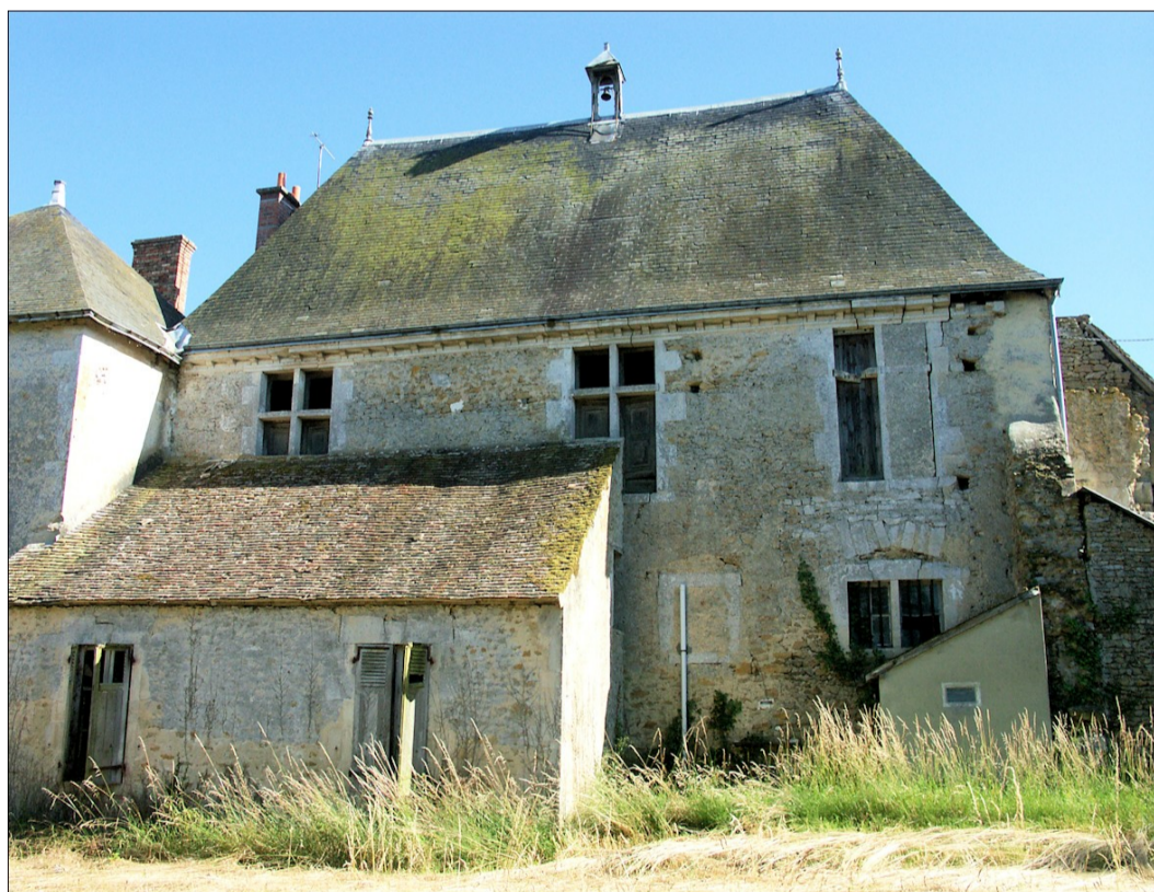
Fig. E.1. Le Logis. La façade nord (avant restauration)
